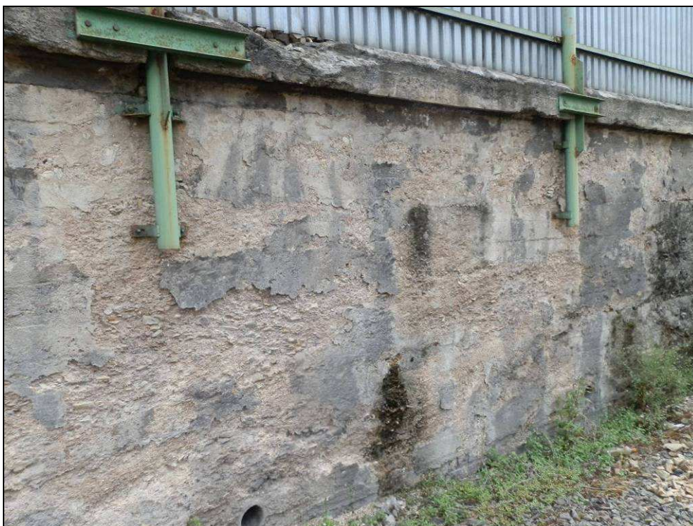
Obr. č. 14 - 4. část OZ km 40,994 - 41,134, detailní pohled na porušený povrch betonu. Tato část OZ je s největšími poruchami vůči zbylým úsekům.
