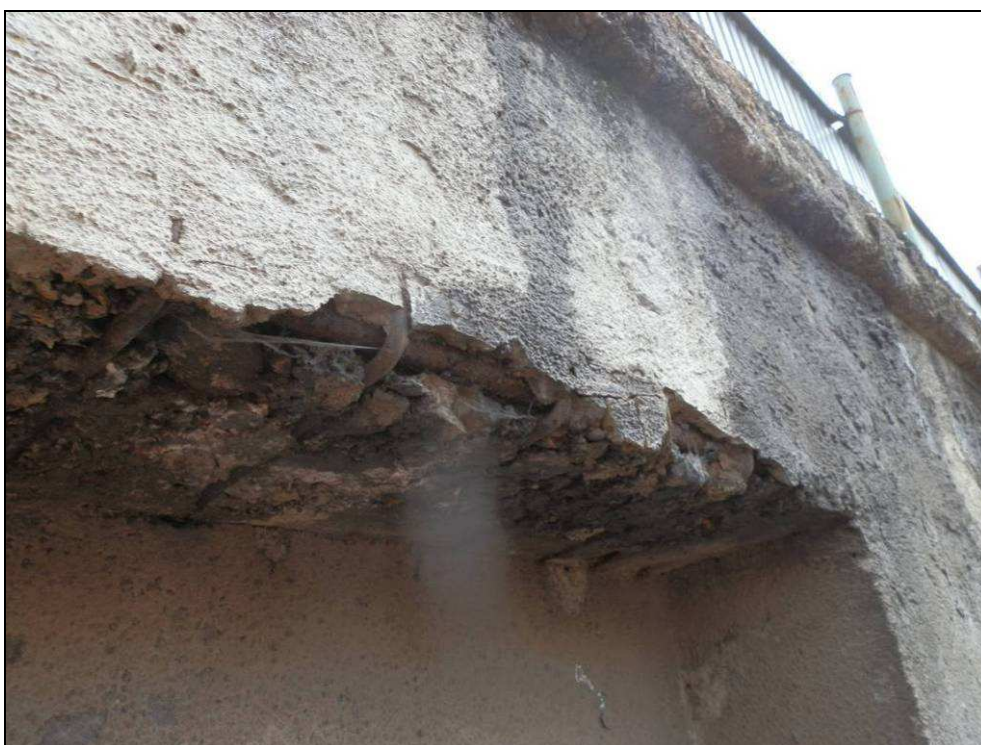
Obr. č. 12 - 3. část OZ km 40,987 - 40,994, detailní pohled na beton římsy s obnaženou tahovou výztuží.
