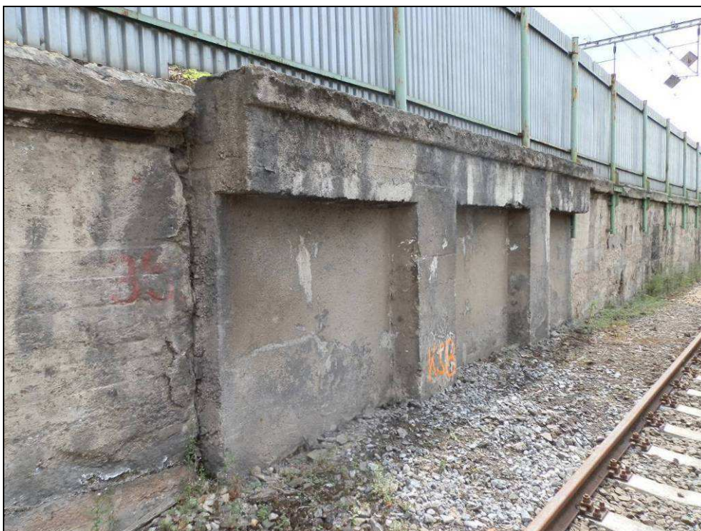
Obr. č. 11 - 3. část OZ km 40,987 - 40,994, jde o úsek délky 17 m, dříve pravděpodobně sloužil jako plošina pro jeřáb. Beton je mimo žebra a římsy zachovalý.
