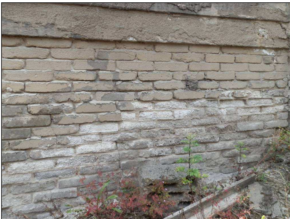
Obr. č. 4 - 1. část OZ km 40,625 - 40,870, detailní pohled na porušené lícové zdivo z betonových cihel. Cihly opadávají. Na poklep zní cca 75% dutě, tzn. že je odděleno od podkladu.
