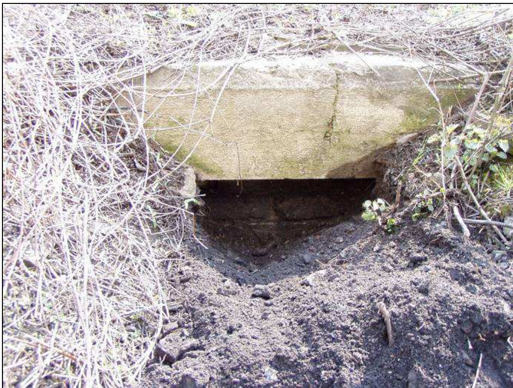
Obr. č. 21 - KS12 pro ověření existence opěrné zdi v km 40,780 - detailní pohled na kopanou sondu s patrnou římsou a cihelnou zdí (pohled)
