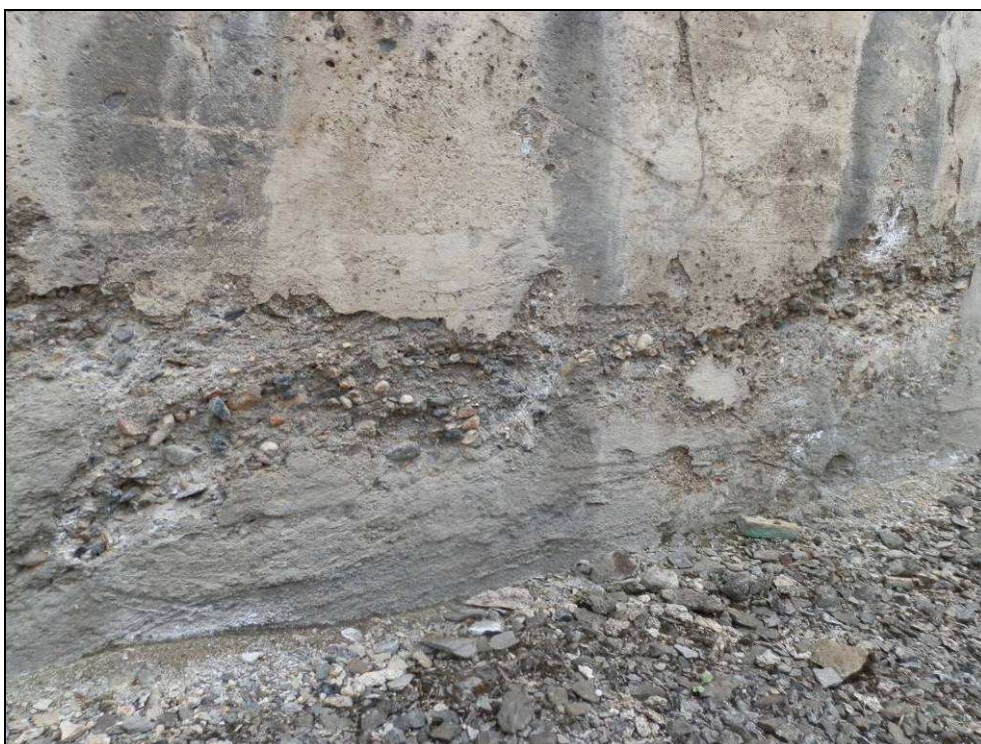
Obr. č. 10 - 2. část OZ km 40,870 - 40,987, detailní pohled na vytříděný beton v líci.
