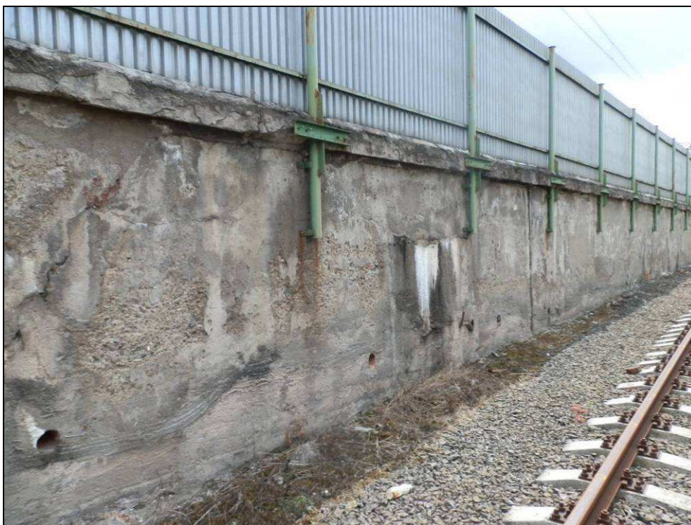
Obr. č. 6 - 2. část OZ km 40,870 - 40,987, pohled na začátek úseku ve směru Plzeň. Povrch betonu je porušený, místy prosakuje voda.
