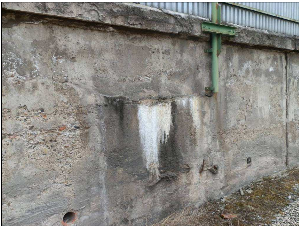
Obr. č. 7 - 2. část OZ km 40,870 - 40,987, detailní pohled na porušení povrchu betonu a průsaky. Beton římsy je porušený a opadává.
