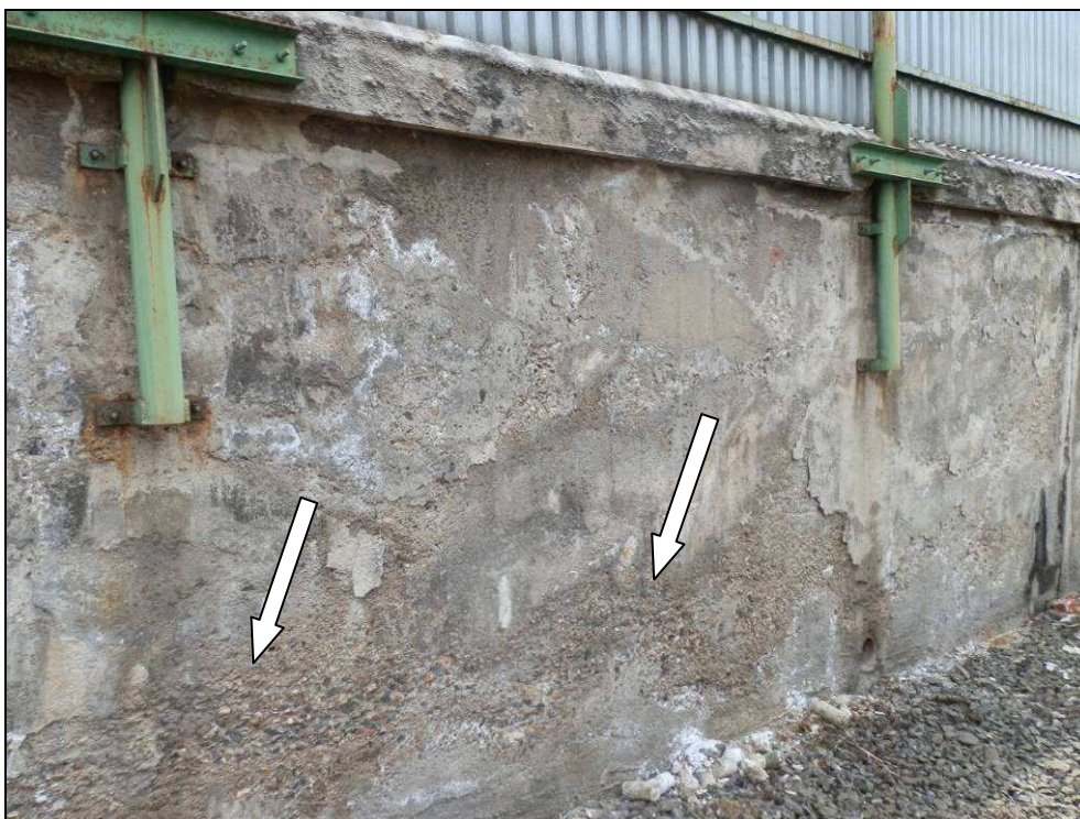
Obr. č. 9 - 2. část OZ km 40,870 - 40,987, detailní pohled na porušený povrch zdi zhruba uprostřed úseku, bílé skvrny jsou v místech průsaků vody, šipka označuje polohy vytříděného betonu s malým obsahem pojiva.
